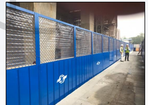
路面密接之施工圍籬
