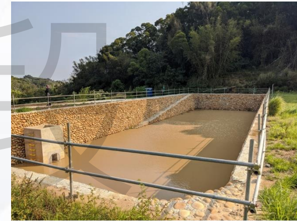
臨時滯洪沉砂池
