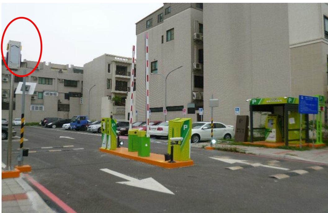
圖 12 東橋八街停車場—出車告警示系統
