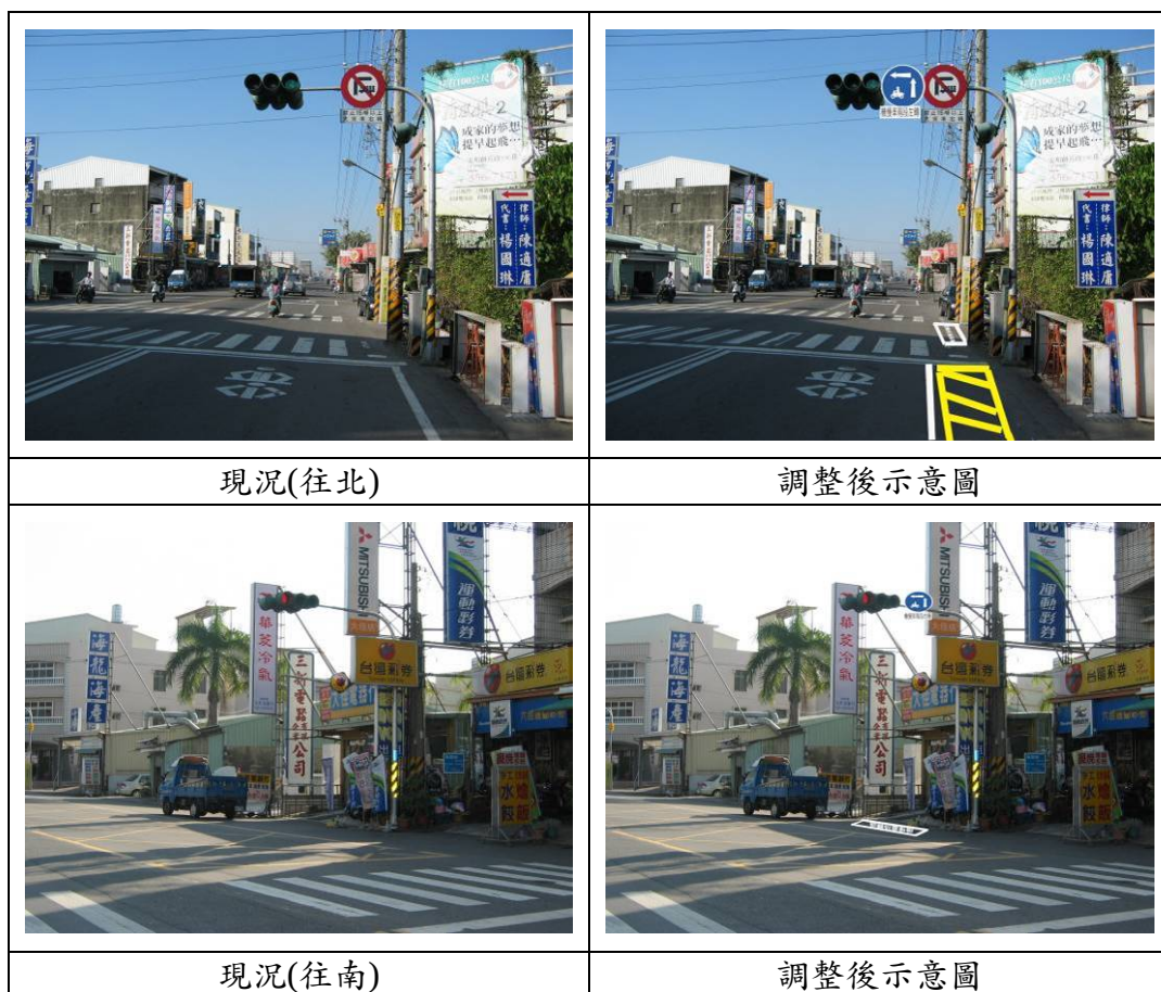
圖 7.10.7 安和路與安和路五段 325 巷、336 巷口機慢車待轉區調整前後示意圖
