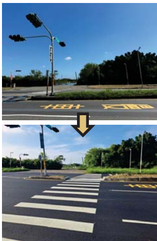
安南區台江大道(庇護島)
