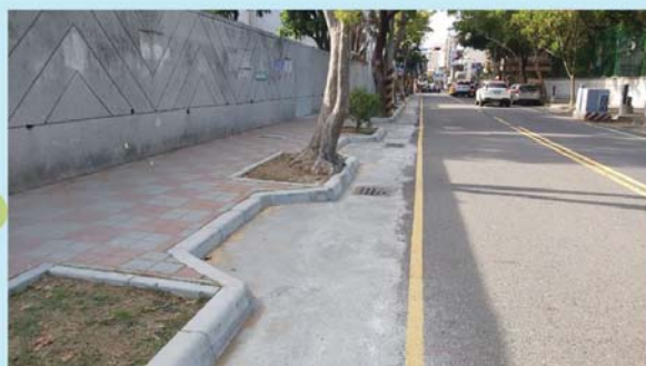
進學國小於忠義路通學步道側面，設計避車彎作為家長機車停等區，減少馬路交通衝擊。
