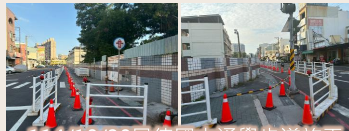
114/10/30民德國中通學步道施工
