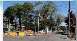
新進國小通學步道 改善工程施工中 57
