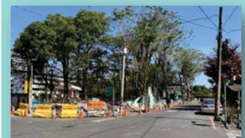
新營區新進國小通學步道改善工程施工中
