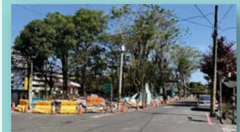
新營區新進國小通學步道改善工程施工中
