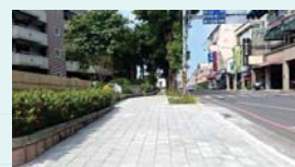
安南國中113年10月完工
